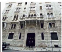
▲ Investimenti La sede storica di Acquedotto pugliese a Bari
